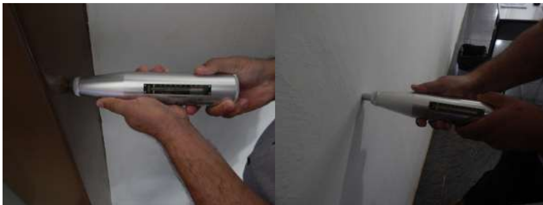
Figura 53: Ensaio não Destrutível de Esclerometria de Reflexão
