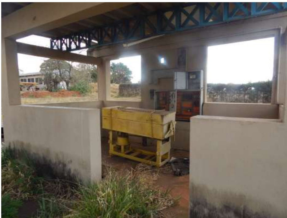
Figura 26: ETA ESTAÇÃO DE TRATAMENTO DE EFLUENTES.
