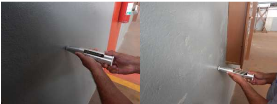
Figura 52: Ensaio não Destrutível de Esclerometria de Reflexão
