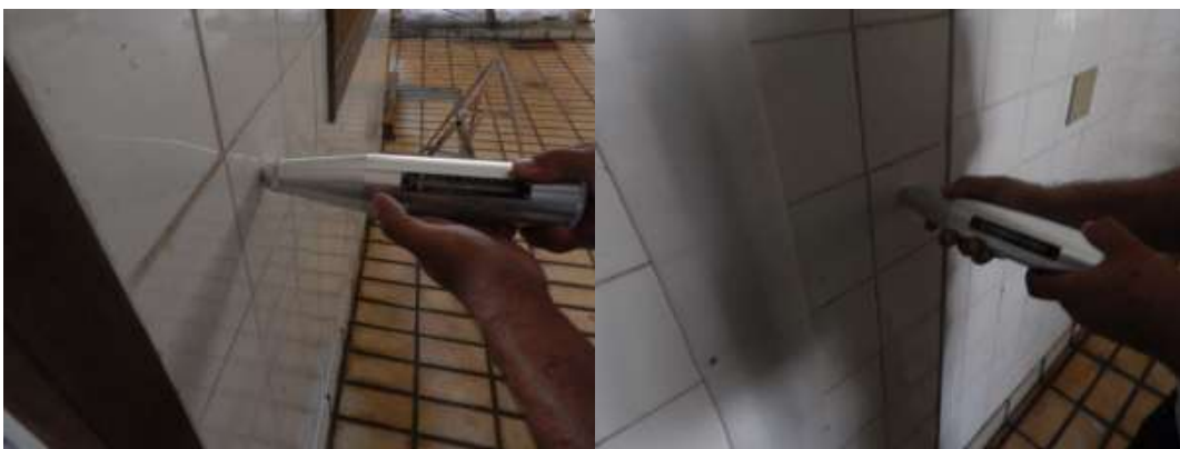
Figura 56: Ensaio não Destrutível de Esclerometria de Reflexão
