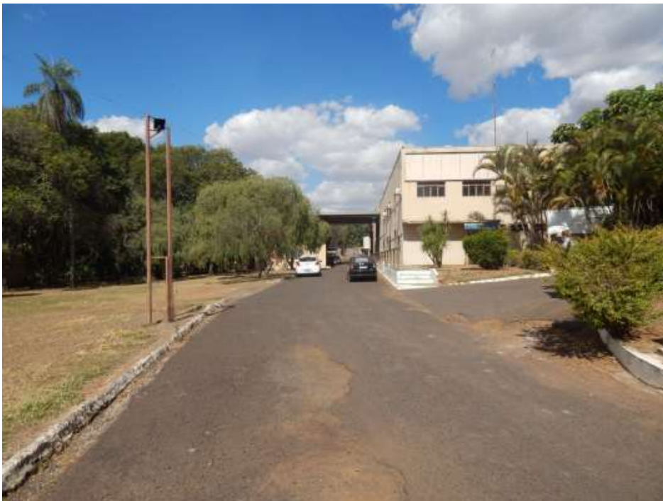
Figura 19: Acesso em asfalto, guias e sarjetas.
